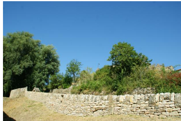
La finition du mur est réalisé par les employés communaux
