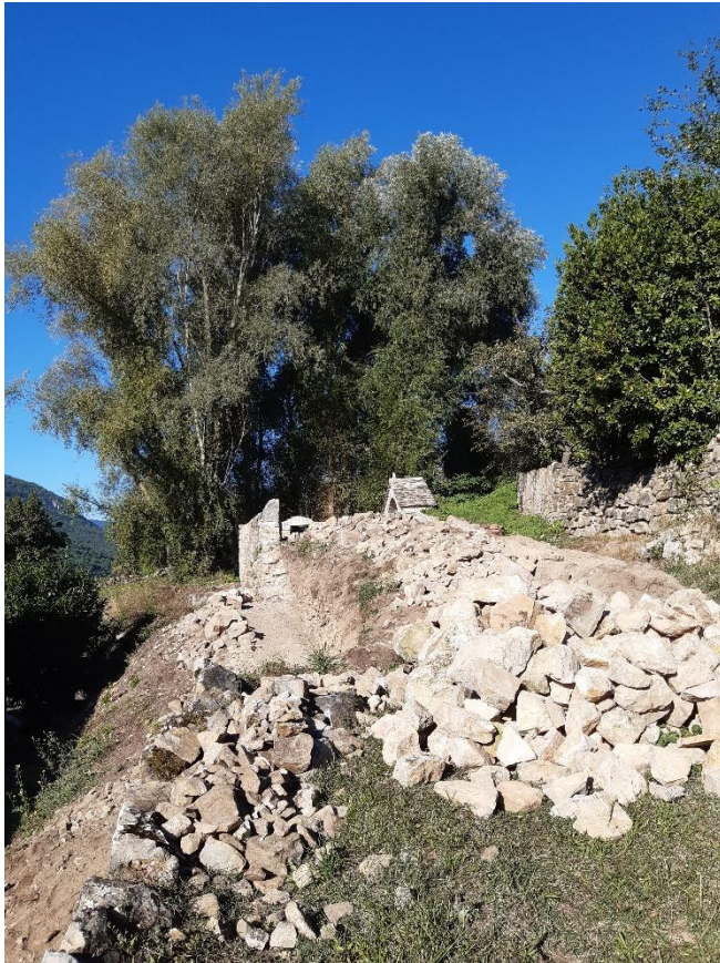
Préparation du chantier : terrassement par les employés communaux
