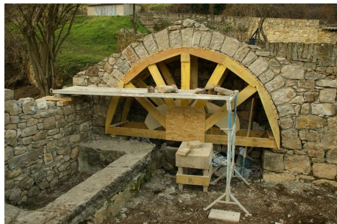
Installation du coffrage de la voûte
