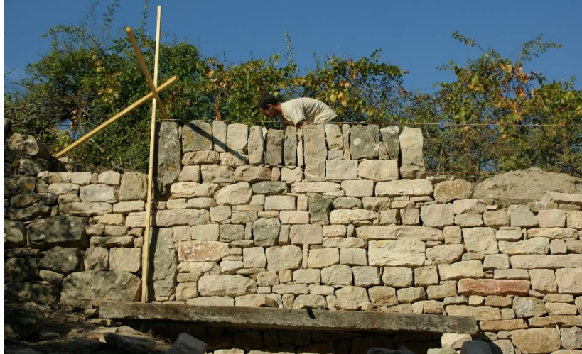
La finition du mur est réalisée par l'ABPS et une entreprise locale
